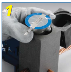
Positionner la capsule CADWELD PLUS dans le moule
